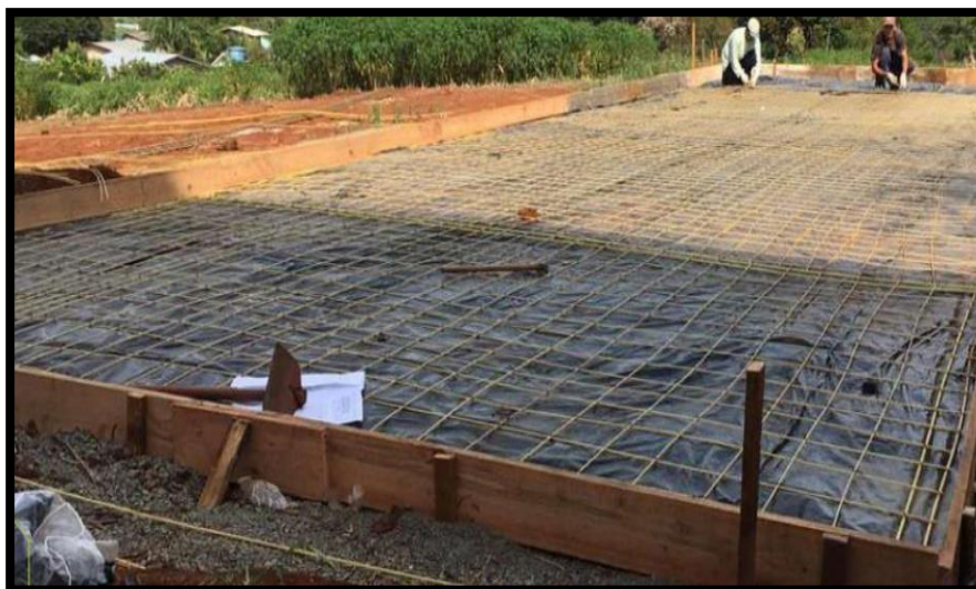
Figura 10 - Uso do vergalhão de fibra de vidro em obra de radier
