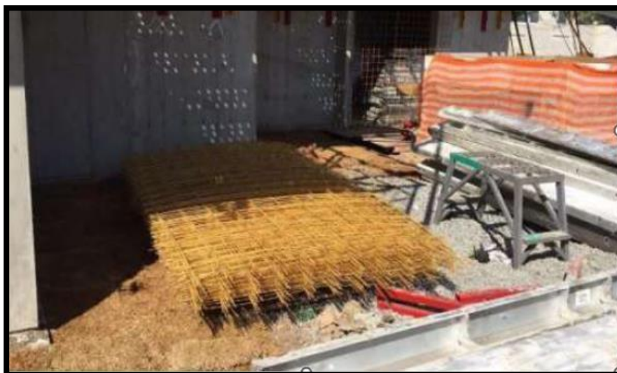
Figura 11 - Armazenamento na obra
