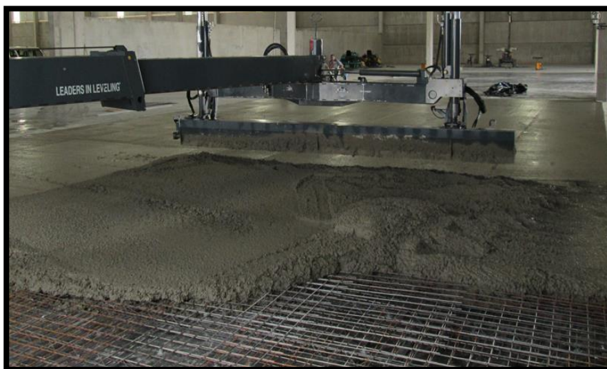
Figura 5 – Execução do piso industrial com uso de maquinários
