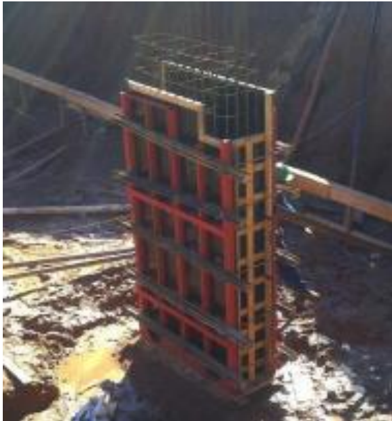
Figura 2 - Forma de madeira em estrutura de pilar
