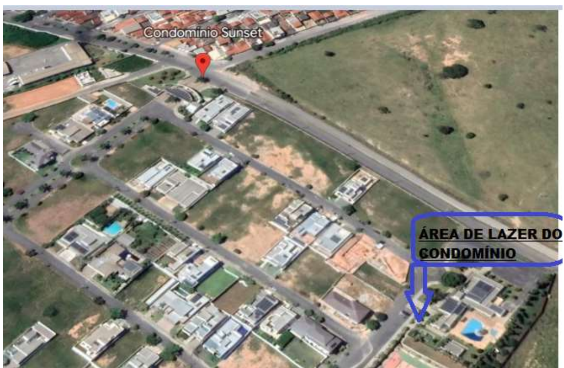
Figura 7 - Área de lazer dentro do Condomínio Sunset
