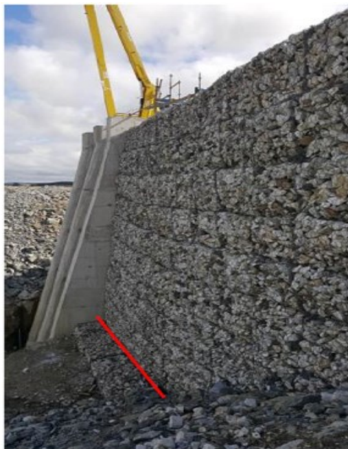
Figura 56 - Alinhamento do pé da estrutura
