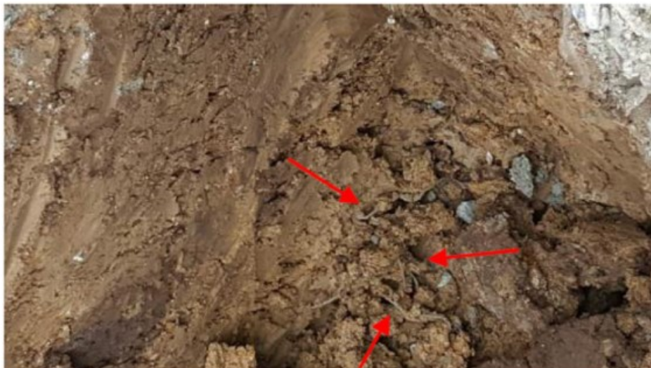
Figura 66 - Trincheira com exposição da malha de ancoragem
