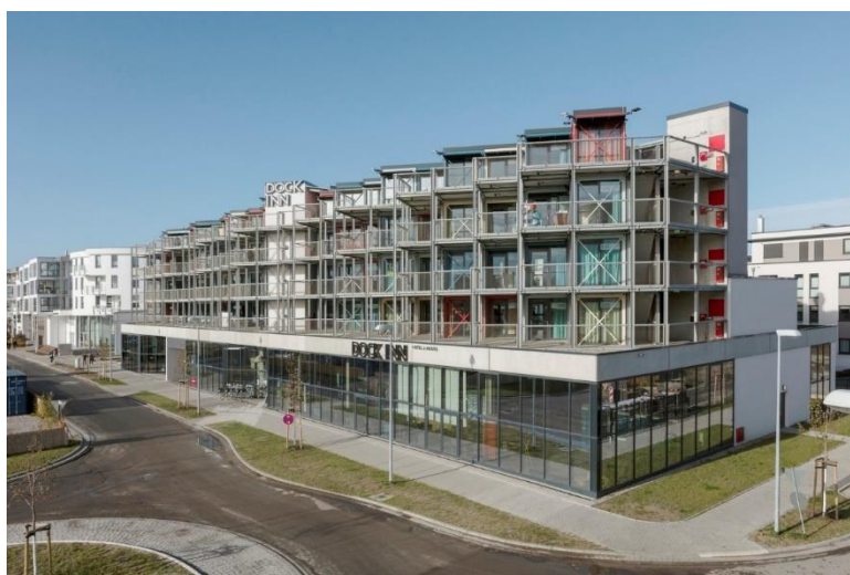
Figura 15- Foto da fachada, volumetria.
