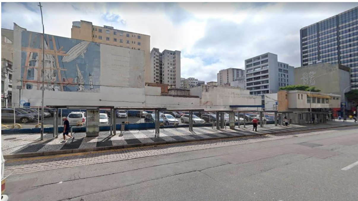
EQUIPAMENTO URBANO 13 – Terreno Escolhido.
