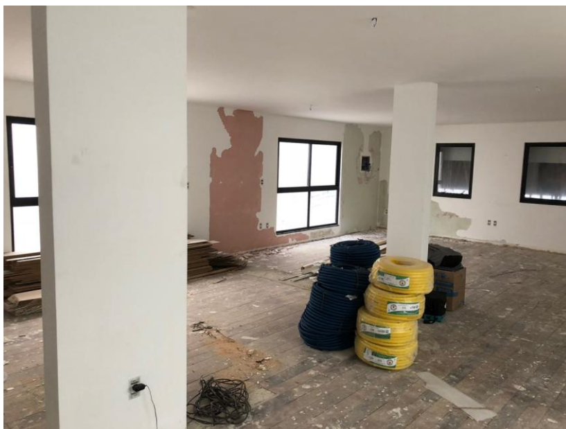
Figura 74 – Área destinada à recepção após retirada do piso laminado e descoberta do mezanino em madeira na clínica Odontocompany de Camboriú
