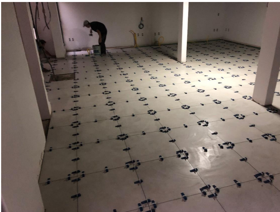
Figura 82 – Colocação de piso porcelanato retificado 62,5x62,5cm na clínica Odontocompany de Camboriú
