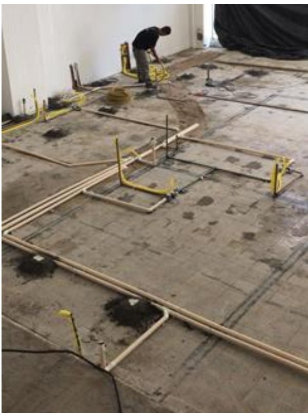
Figura 6 – Teste das tubulações de infraestrutura da clínica Odontocompany de Florianópolis
