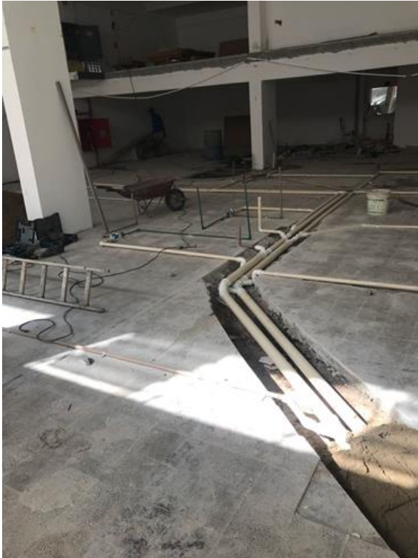
Figura 5 – Execução das infraestruturas das cadeiras odontológicas na clínica Odontocompany de Florianópolis 71
