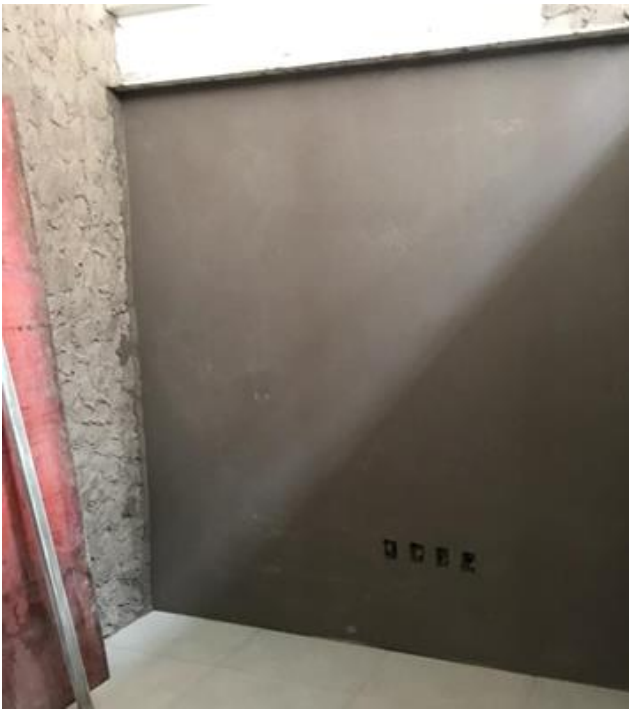
Figura 24 – Parede após a segunda etapa de aplicação da argamassa baritada desempenada na sala de Raio-X Panorâmico da clínica Odontocompany de Florianópolis
