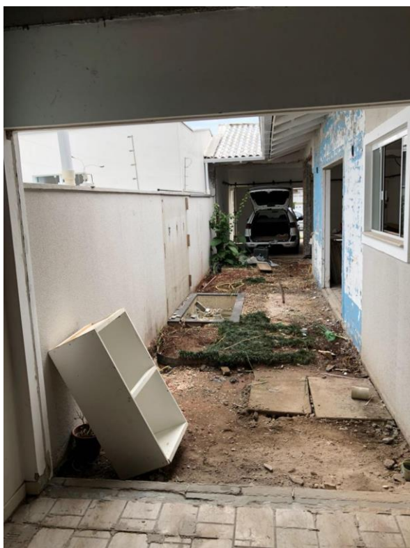
Figura 57 - Remoção do jardim de inverno e esquadrias do imóvel.
