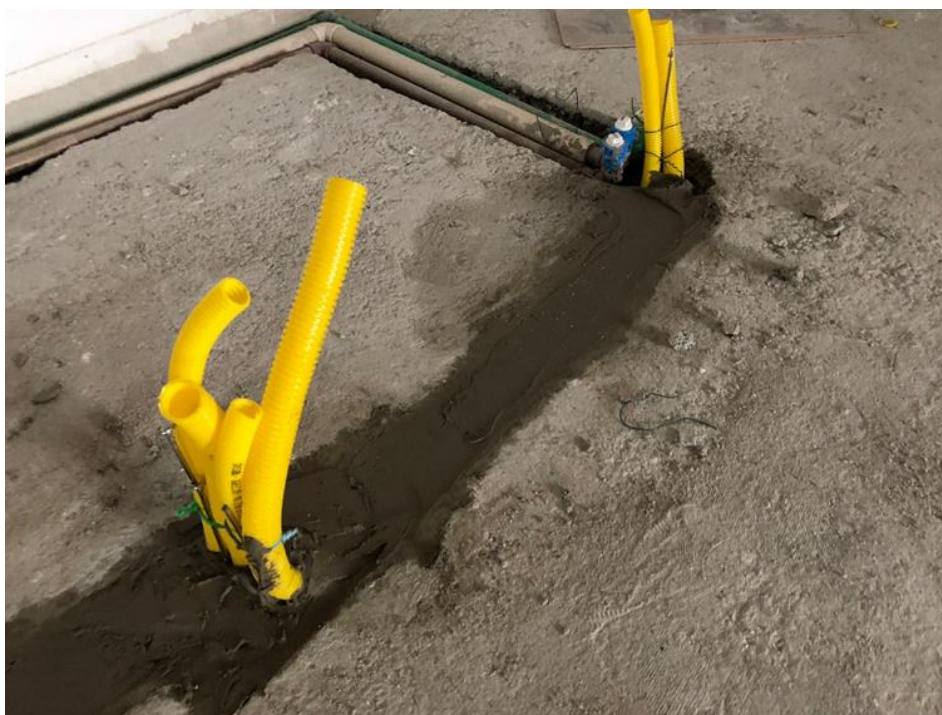
Figura 81 – Início do chumbamento das tubulações de infraestrutura de água fria, ar comprimido, esgoto, alimentação elétrica e cabo de rede das cadeiras odontológicas da clínica Odontocompany de Camboriú
