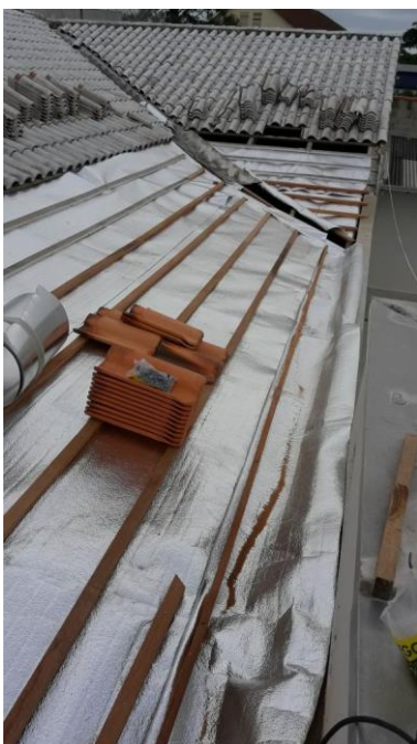
Figura 61- Construção do telhado do antigo jardim de inverno do imóvel
