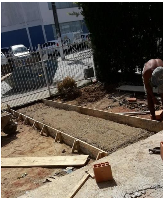
Figura 56 - Caixaria da rampa de acesso dos pedestres no estacionamento do imóvel
