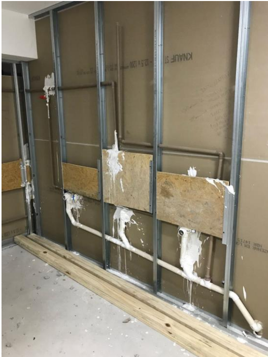
Figura 32 - Chumbamento com pó de gesso misturado com sisal e reforço para fixação dos lavatórios da clínica Odontocompany de Florianópolis
