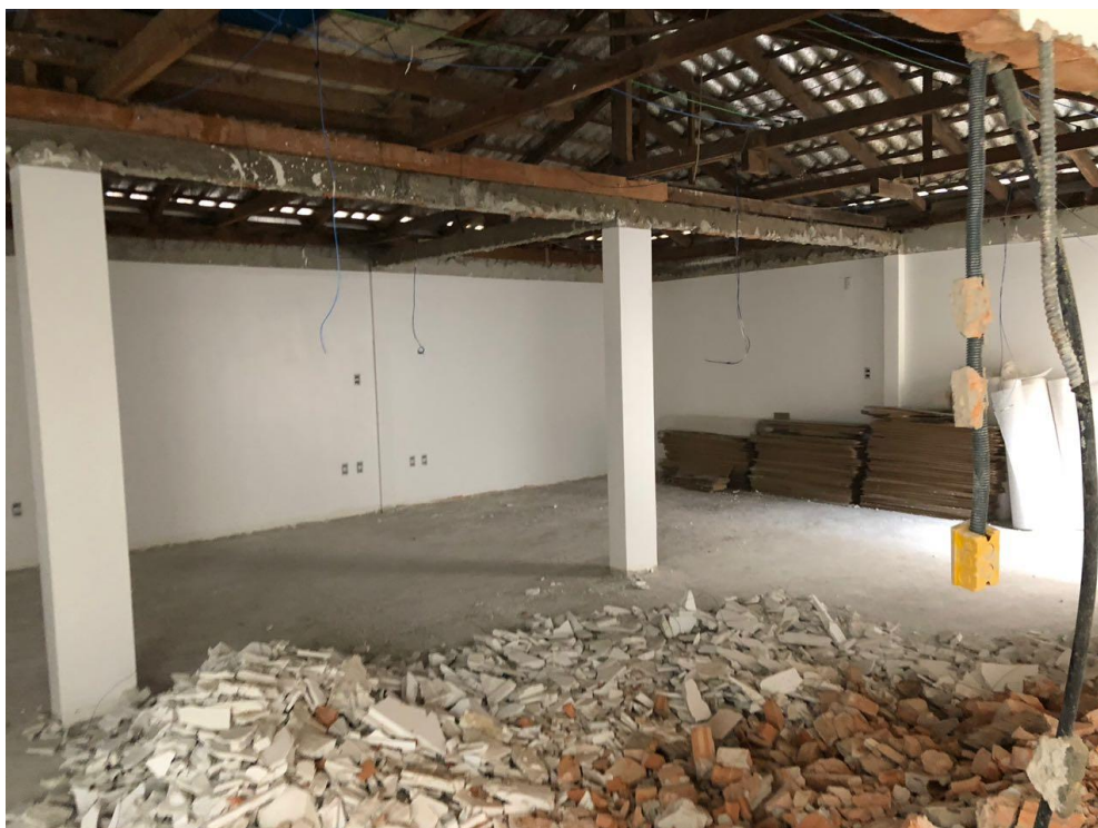
Figura 76- Área destinada aos consultórios após remoção do forro para facilitar passagem de infraestrutura na clínica Odontocompany de Camboriú
