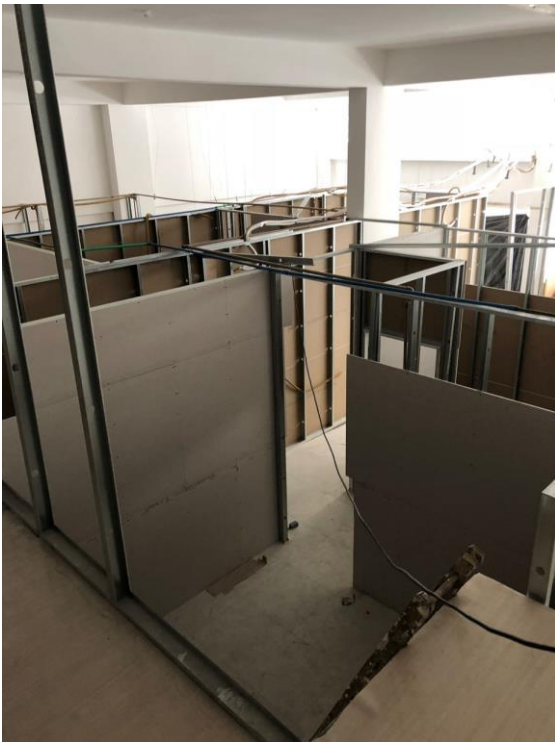
Figura 40 – Vista superior do plaqueamento de um lado das divisórias na clínica Odontocompany de Florianópolis
