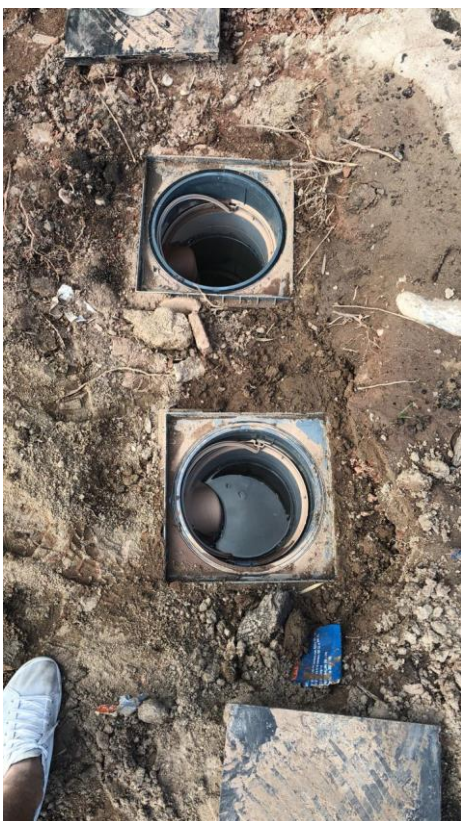
Figura 60 - Teste das tubulações hidrossanitárias do ramal de esgoto das cadeiras odontológicas e dos lavatórios
