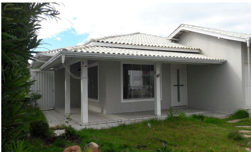
Figura 51 - Porta de entrada do imóvel residencial antes do início da obra
