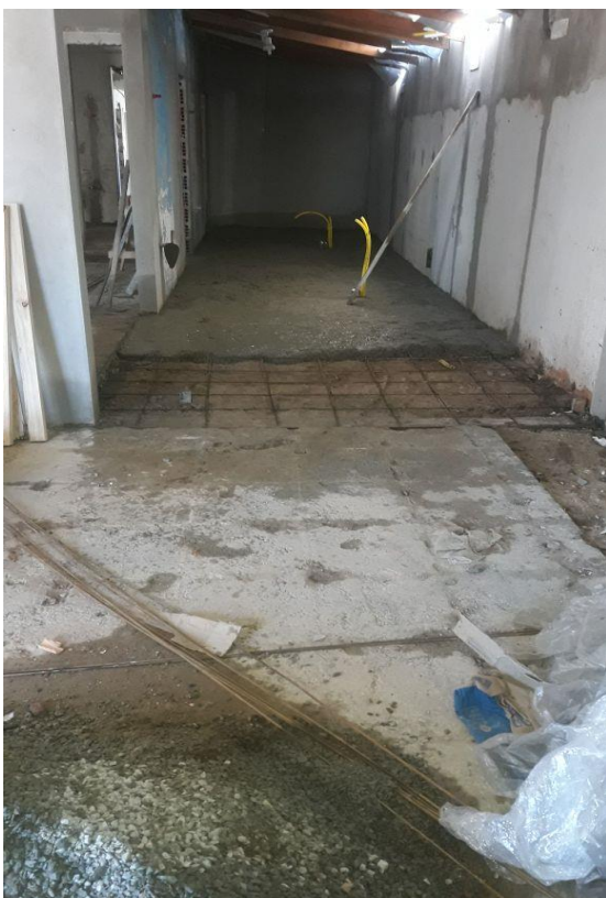
Figura 59 - Reconstrução do contrapiso dos consultórios odontológicos e recepção
