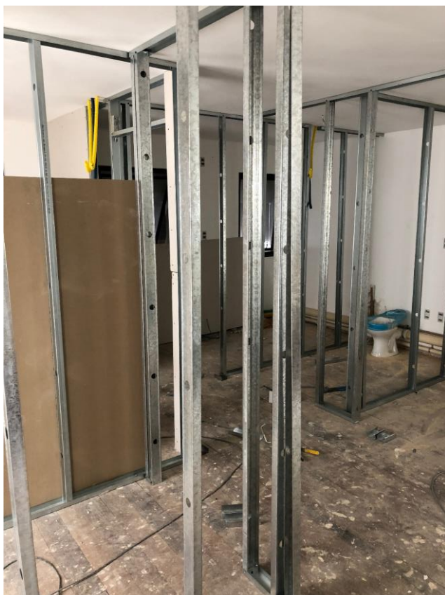
Figura 88 – Estrutura das paredes de drywall na clínica Odontocompany de Camboriú
