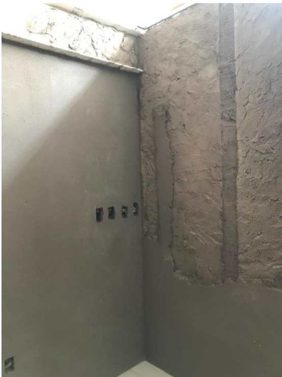
Figura 23 – Preenchimento dos buracos das régulas da sala de Raio-X Panorâmico da clínica Odontocompany de Florianópolis.
