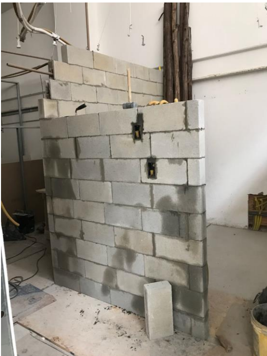
Figura 21 – Paredes tubuladas da sala de Raio-X Panorâmico da clínica Odontocompany de Florianópolis
