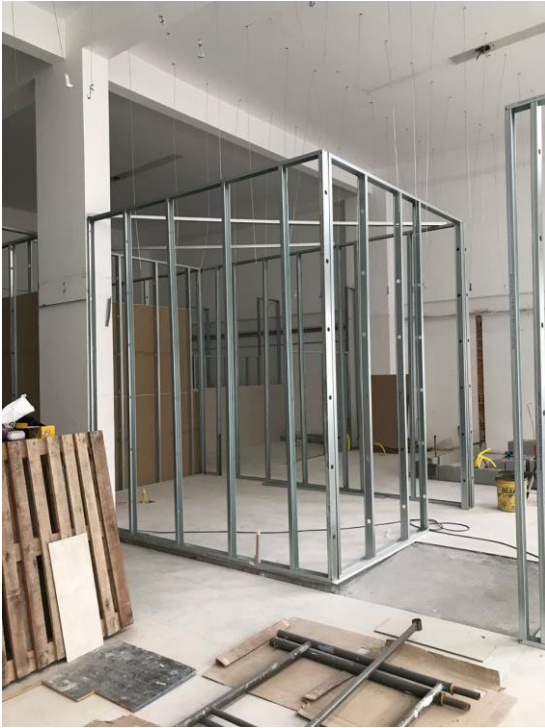
Figura 38 - Fixação dos montantes nas guias a cada 60cm entre eixos na clínica Odontocompany de Florianópolis
