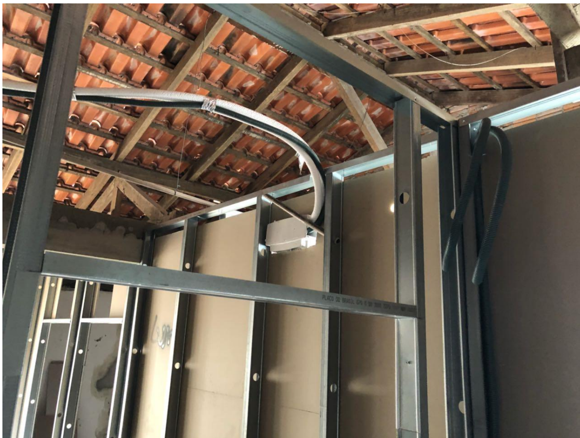
Figura 62 - Estrutura do drywall e infraestrutura da máquina de ar condicionado da área técnica
