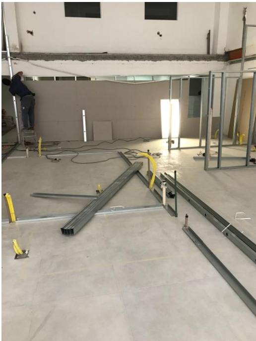
Figura 36 – Fixação no chão das guias de 7cm na clínica Odontocompany de Florianópolis
