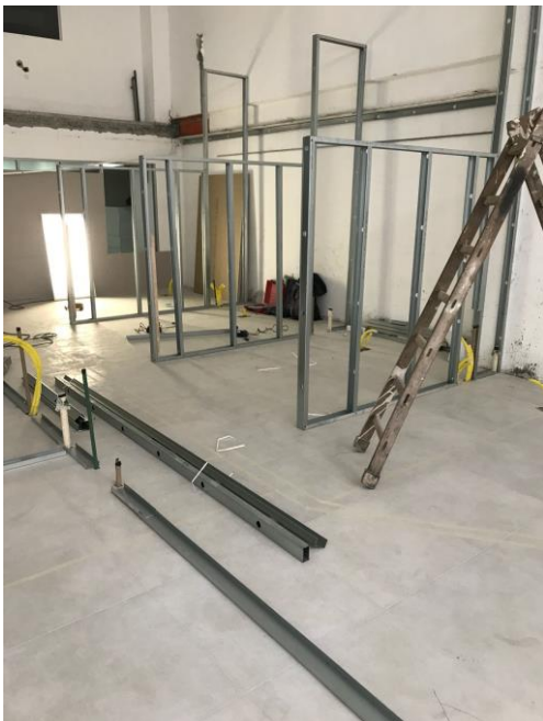
Figura 37 - Fixação dos montantes nas guias a cada 60cm entre eixos na clínica Odontocompany de Florianópolis
