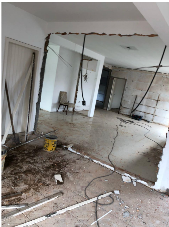
Figura 55 - Remoção da parede de alvenaria entre a garagem e a sala de estar
