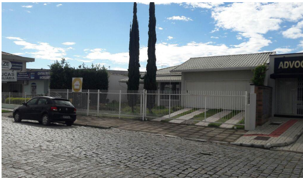
Figura 50 - Fachada do imóvel residencial antes do início da obra
