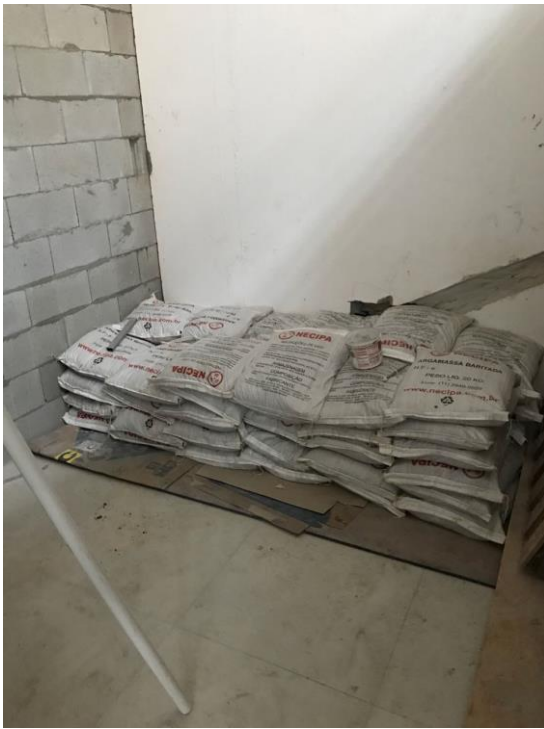
Figura 22 – Armazenamento das sacas de argamassa baritada conforme recomendações técnicas na sala de Raio-X Panorâmico da clínica Odontocompany de Florianópolis.
