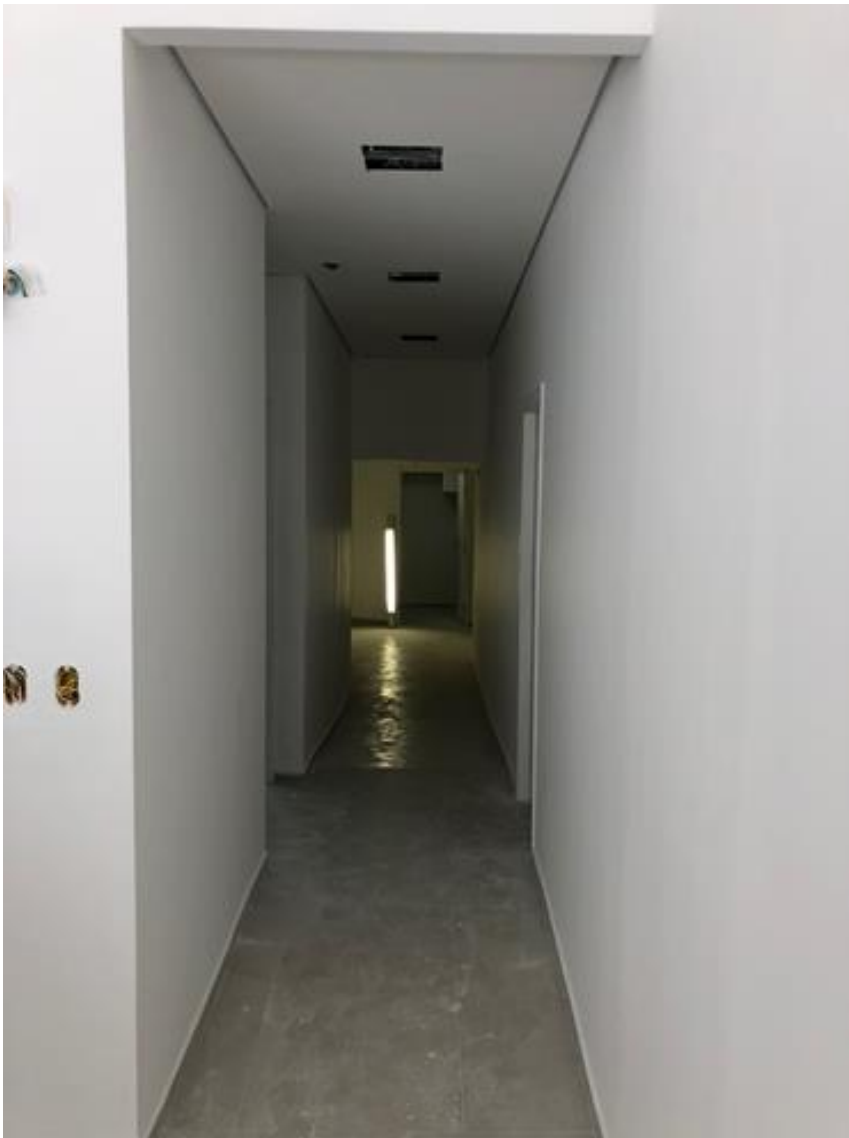
Figura 42 – Primeira demão de tinta acrílica nas divisórias da clínica Odontocompany de Florianópolis
