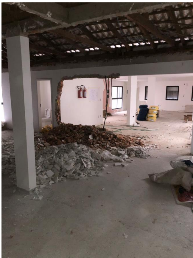
Figura 75- Área destinada aos consultórios após remoção do forro para facilitar passagem de infraestrutura na clínica Odontocompany de Camboriú
