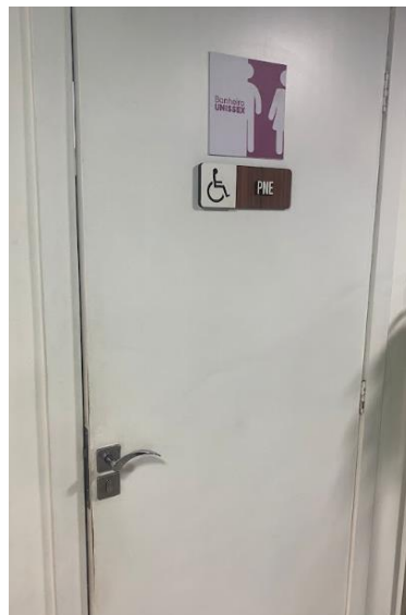
Figura 8 - Banheiro com acessibilidade na Academia 4
