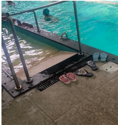
Figura 9 - Rampa de acesso à piscina na Academia 4
