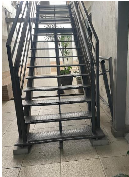
Figura 2 - Escada no ambiente interno da academia 1
