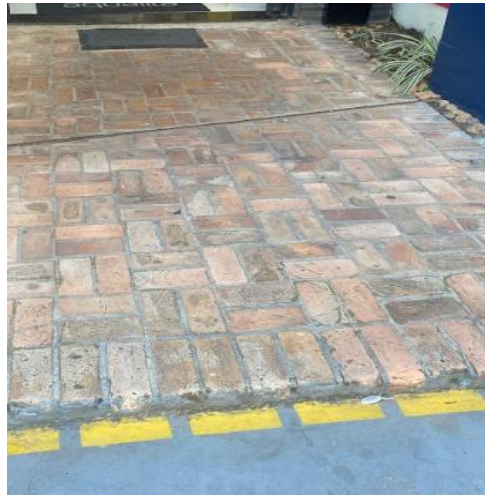
Figura 13 - Degrau de acesso da Academia 4
