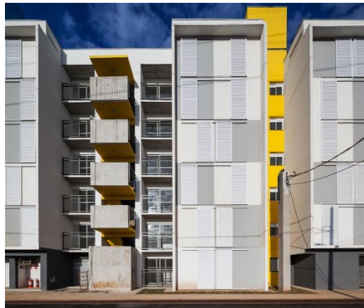
Figura 03 – Detalhe / SEHAB Heliópolis
