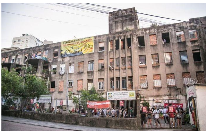
Figura 7 — Vista da fachada do edifício
