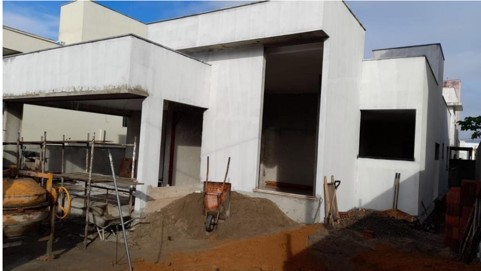
Figura 10 - Canteiro de Obras
