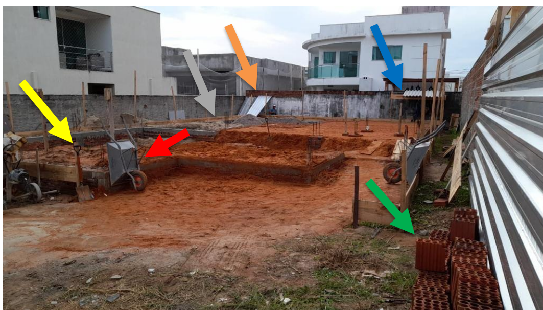
Figura 9 - Canteiro de Obras
