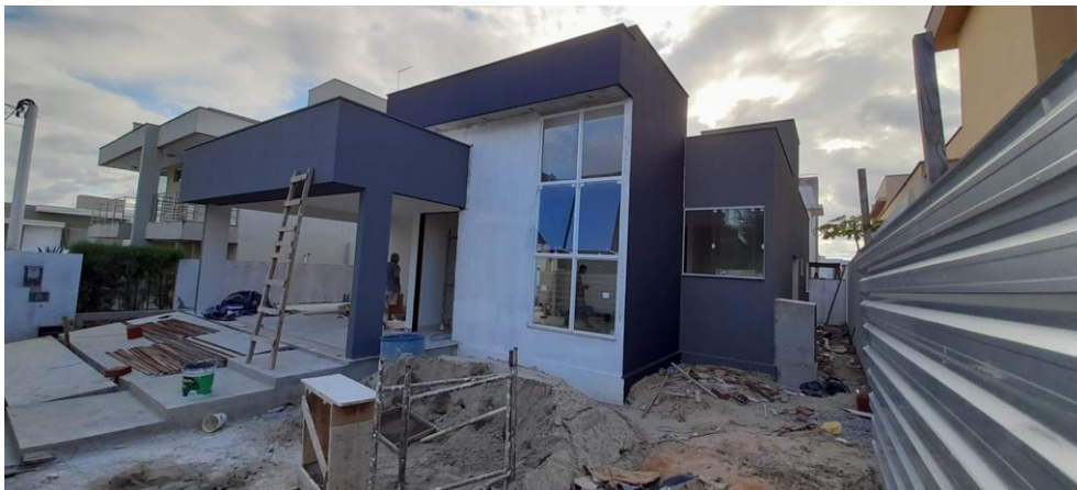
Figura 11 - Canteiro de obra
