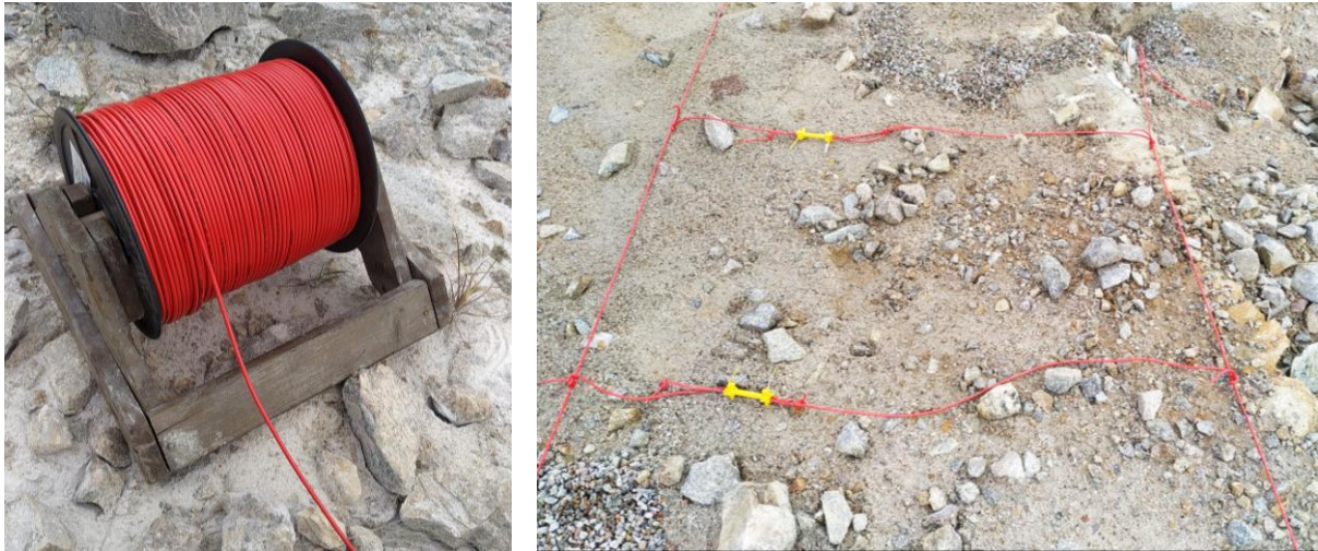
Figura 19 - Bobina de cordel detonante e ligações entre furos
