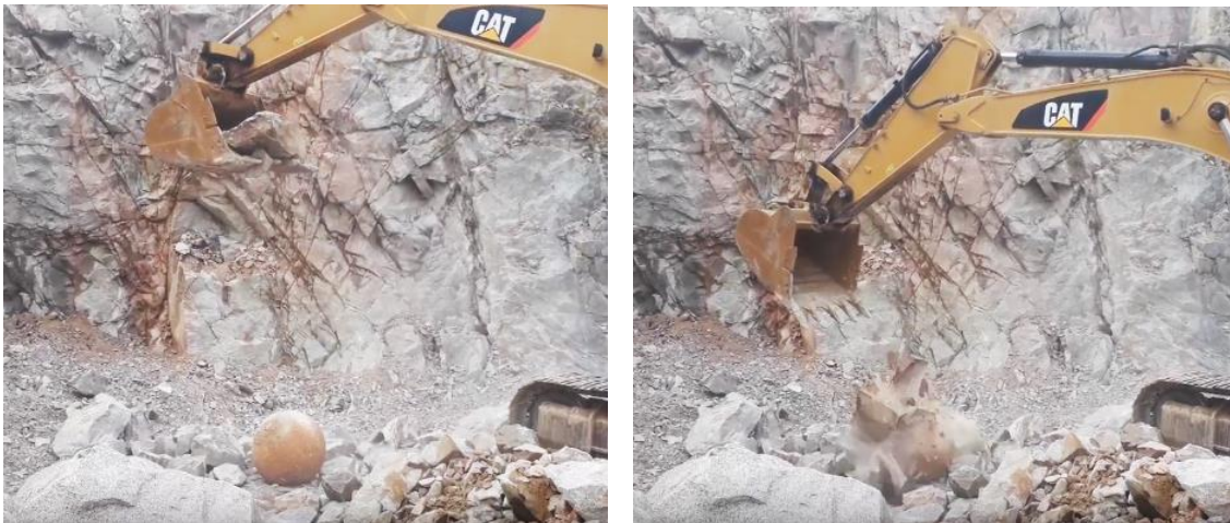
Figura 23 - Fragmentação de matacos com utilização de bola de aço
