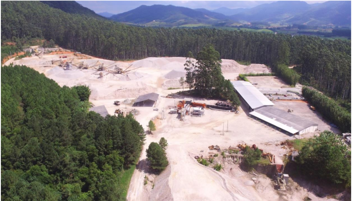
Figura 12 - Instalações da pedreira situada no município de Tijucas, Santa Catarina
