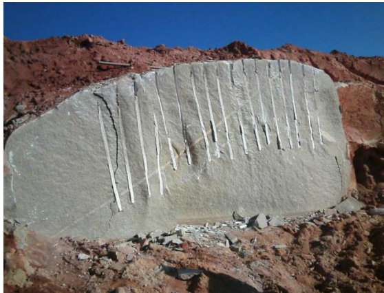
Figura 4 - Desmonte com argamassa expansiva
