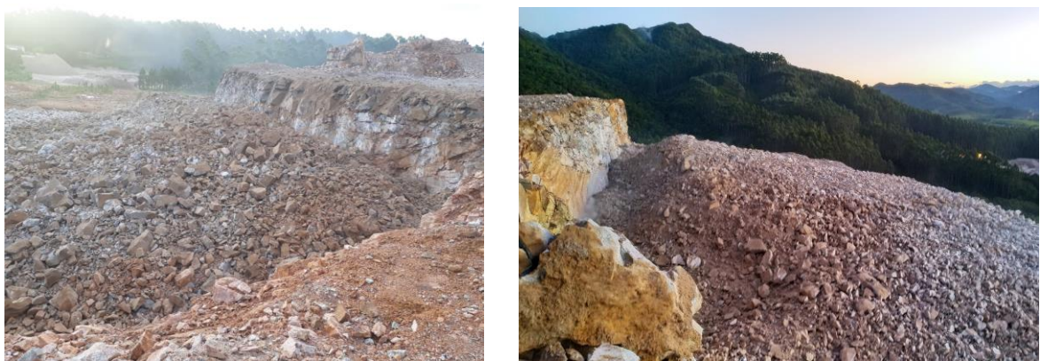
Figura 22 - Pilha de material proveniente dos desmontes 1 e 2
