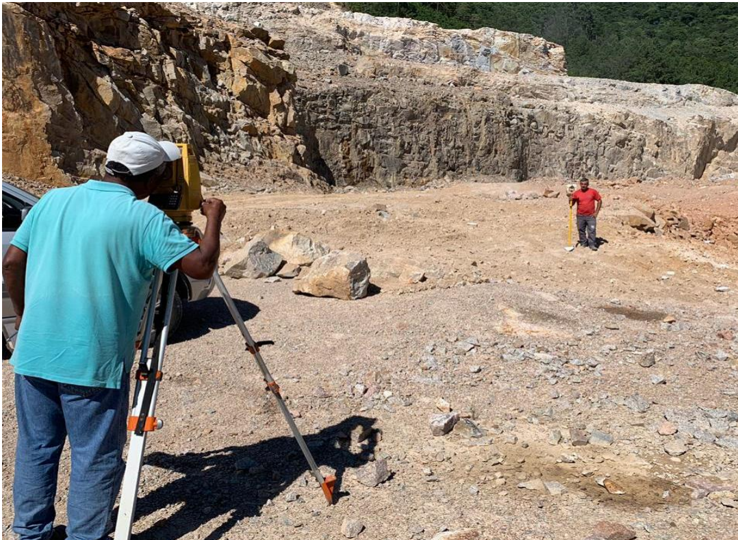
Figura 14 - Marcação dos furos por topografia
