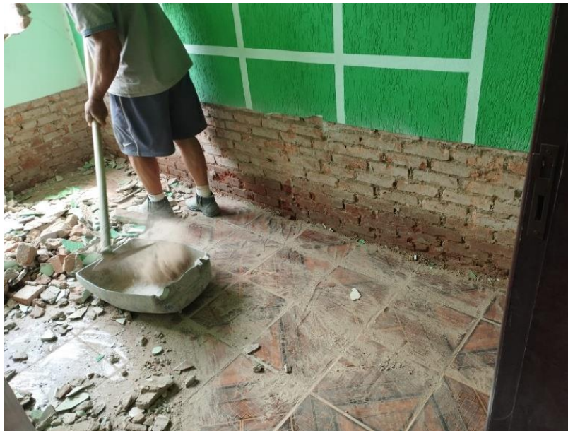
Figura 15: Remoção do reboco.
