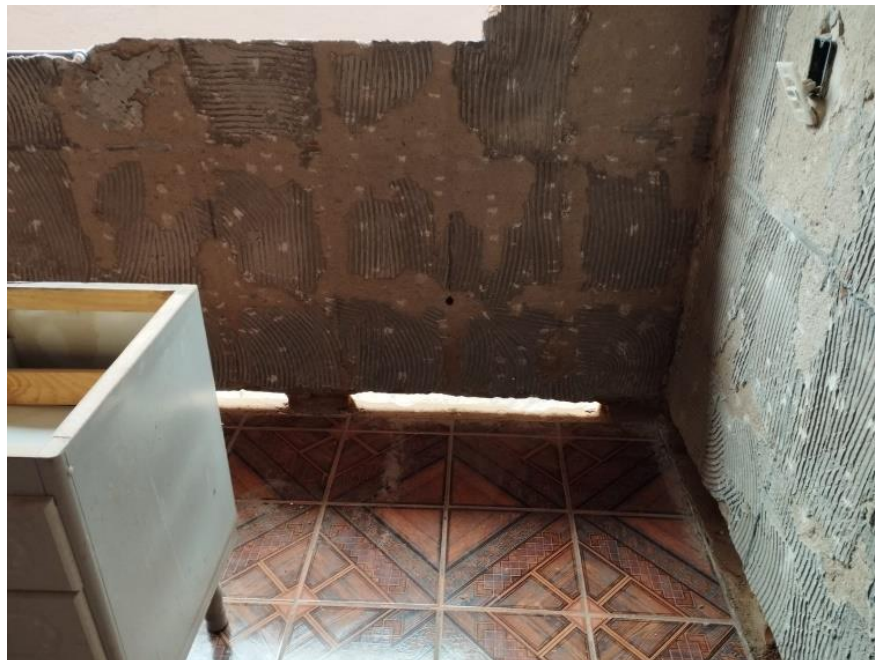
Figura 16: Escavação da parede.
