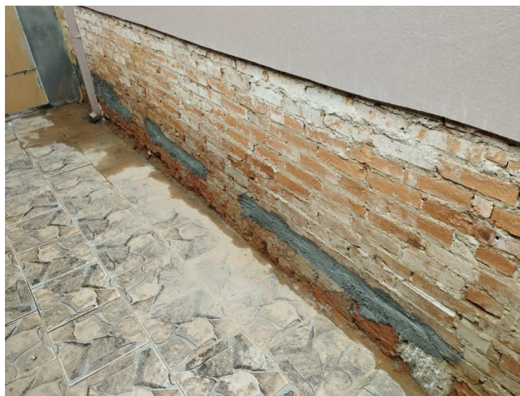
Figura 17: Aplicação da argamassa com impermeabilizante.
